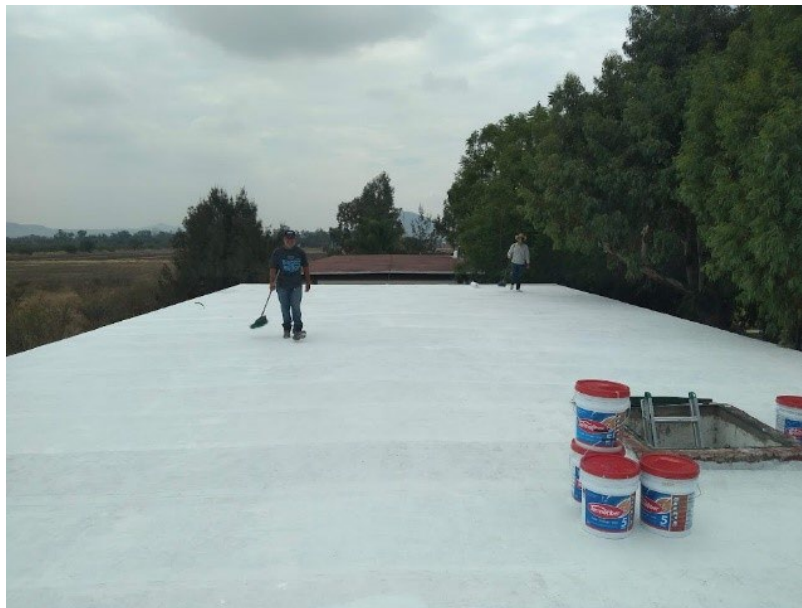
Imagen 20. Impermeabilización del Edif. "D".
