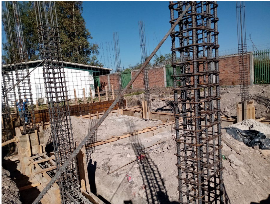
Imagen 13. Obra de dos aulas didácticas.
