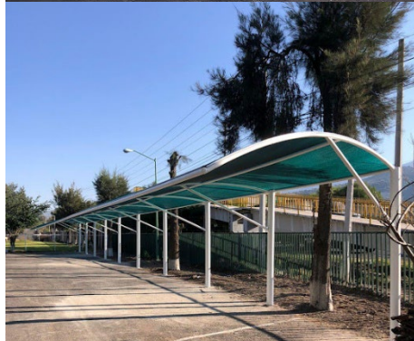
Imagen 25. Instalación de estructura de toldo con malla sombra en estacionamiento.
