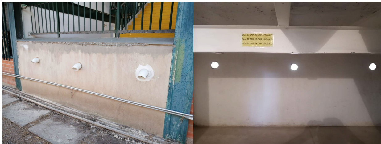
Imagen 26. Mantenimiento al área de archivo del Departamento de Servicios Escolares.
