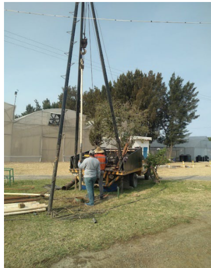
Imagen 21. Mantenimiento preventivo al pozo profundo.
