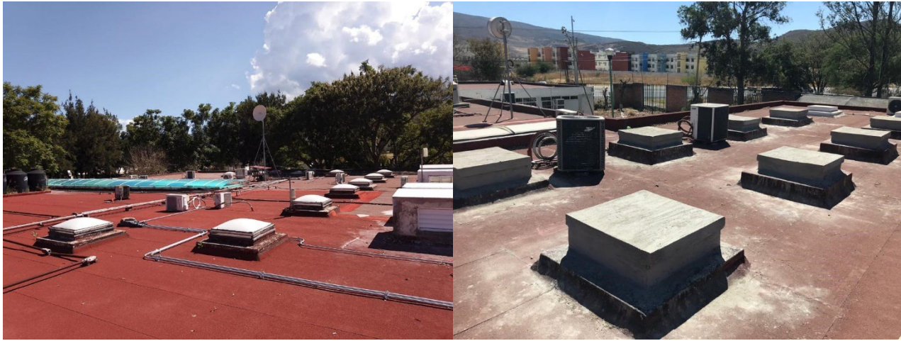
Imagen 17. Instalación de loza en domos del laboratorio de biotecnología vegetal.
