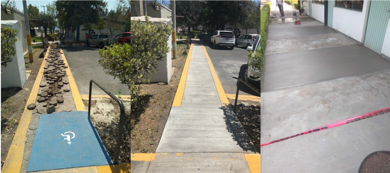
Imagen 22. Reparación y mantenimiento a pasillos de áreas comunes.
